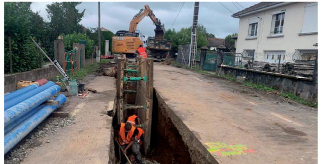
La CCPL a procédé au remplacement de la conduite d'eau potable et des branchements aux particuliers sur 720 mètres linéaires (310000 €). Reprise ponctuelle du réseau d'assainissement (210000 €). Des travaux de réfection de la chaussée auront lieu au printemps prochain.
